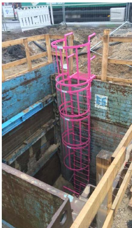
entwickelt. Ähnlich einer Steigleiter besitzt sie Podeste an Ein- und Ausstieg in Form von Gitterrosten und ist auf ganzer Länge bis zur Grubensohle mit einem Rücken-schutz versehen. Rutschhemmende Trittplätze und eine Sicherung am Leiterkopf sind weitere Sicherheitskomponenten. Je nach Höhenunterschied lässt sich die Verbauleiter abschnittsweise erweitern. Für Gruben mit Spundwänden wurde eine darauf abgestimmte Variante entwickelt. Mit beiden Leitertypen gelangen Beschäftigte gut gesichert
