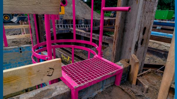
Eingehängte Verbauleiter. Die Leiter muss vollflächig und formschlüssig aufliegen
