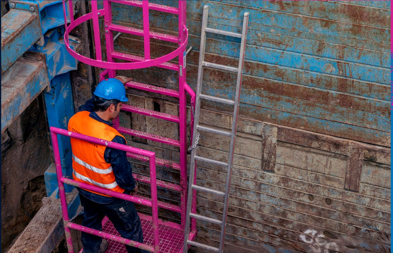
Das letzte Stück des Abstiegs in die Baugrube wird durch eine Anlegeleiter realisiert. Diese kann beidseitig am unteren Podest der Verbauleiter angebracht werden.
