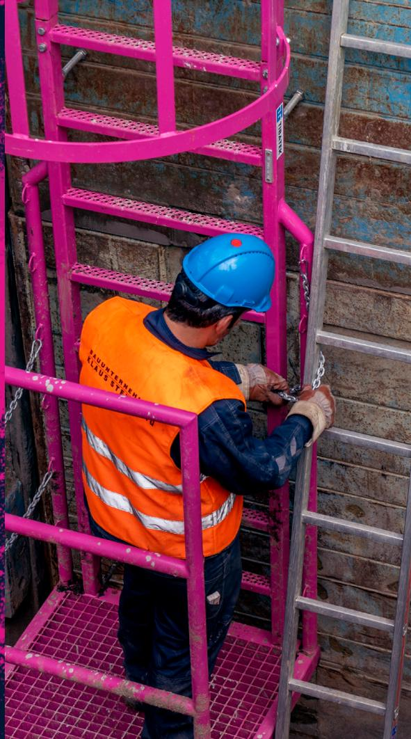
Die Leiter wird an der Anlegeseite mittels einer Kette so stramm wie möglich um den Leiterholm fixiert, um ein seitliches Kippen zu verhindern.
