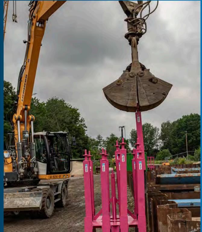
Entnehmen des Geländerpfostens mittels Bagger und Greifer
