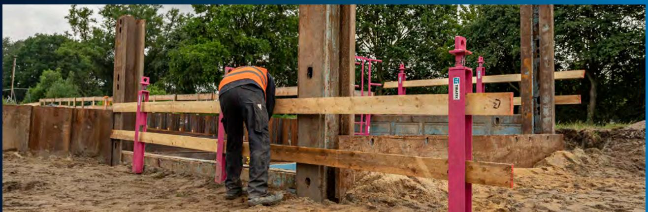
Beide Querriegel fertig eingeschoben. Die Höhe bis zur Oberkante des oberen Riegels beträgt ca. 1150 mm.
