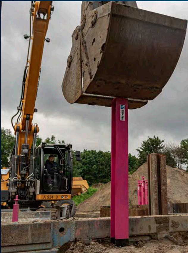
Geländerpfosten mit dem Bagger senkrecht in den Boden drücken.
